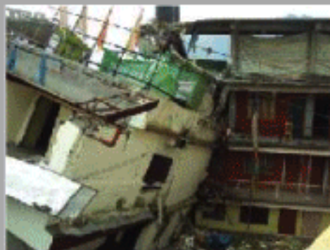
गान्तोकको बालुखानीमा क्षतिग्रस्त बनेको भवन
